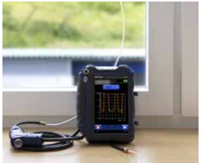
Test 4 Pa – verifica dei 4 Pa secondo UNI 10738 e UNI 10683 per controllare l'efficienza della ventilazione del locale d'installazione.
