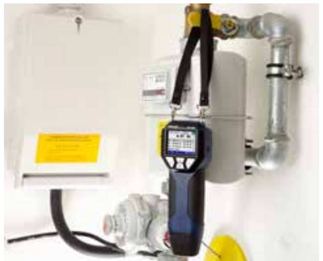
Prova di tenuta senza togliere il contatore gas
