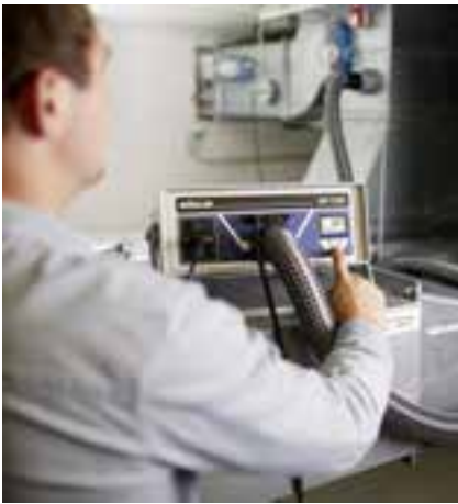
Prova di tenuta su canali di ventilazione
