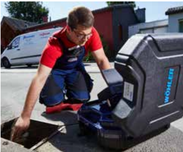
Testata a tenuta all'acqua permette una rapida videoispezione negli scarichi fognari
