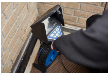
Abb. 9: Kabeltrommelkamera auf dem Boden positioniert
