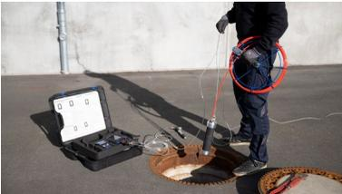
Fig. 68: Inserimento del soffietto terminale
