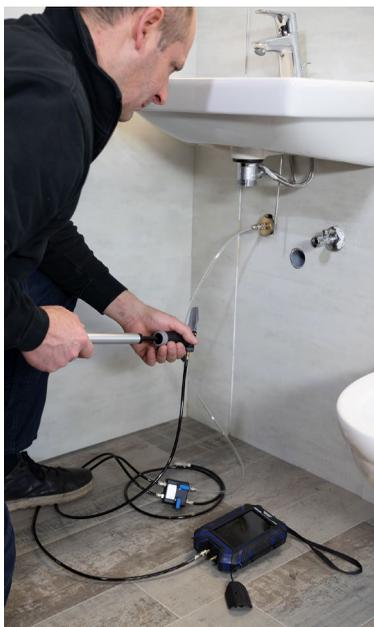
Fig. 50: Caricamento della pressione con pompa a mano
