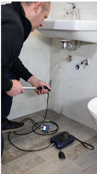
Fig. 55: Prova meccanica con aria
