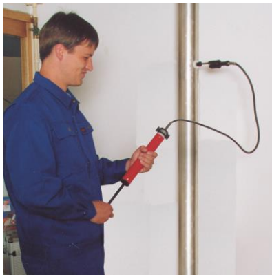
Image 4: Prélèvement des gaz de fumée
